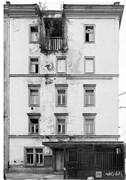
Um in Fotos messen zu können, werden sie entzerrt
